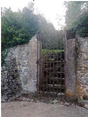
L'accès depuis la rue du Doux
