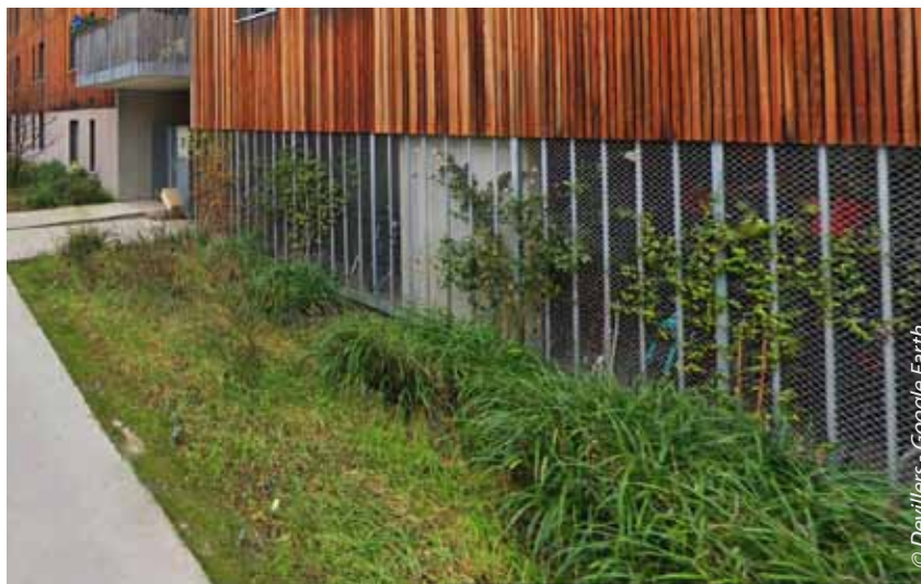
Terre fertile, noue d'infiltration et végétalisation en RDC, Écoquartier Danube, Strasbourg (67) ▼
