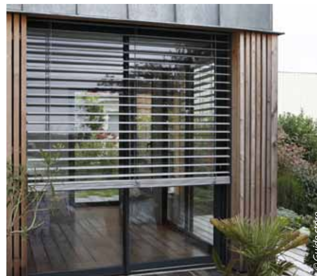
Exemple de brises-soleil orientables intégrés dans les menuiseries ▼
