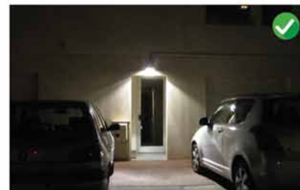
Luminaire type applique, éclairant le sol
