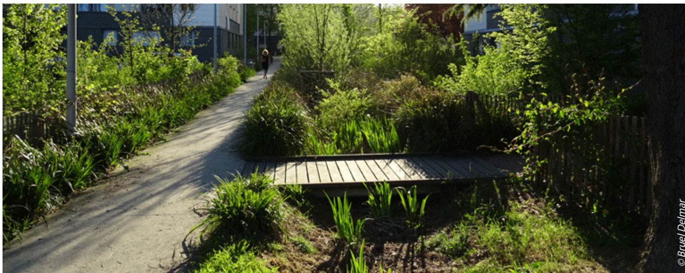
Exemple de noue d'infiltration, Résidence du Pavé Blanc, Clamart (92) ▼
