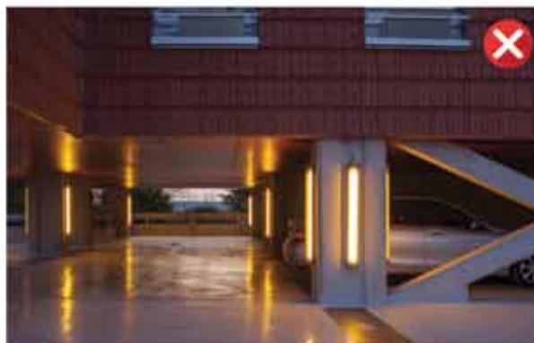
Luminaire orienté vers le sol et l'intérieur du parking
